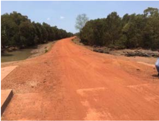
ទំនប់ការពារទឹកសមុទ្រនៅភូមិតានី ២ (១ គីឡូម៉ែត្រ) ឃុំ ជីតរលើ ស្រុកស្រែអំបិល។ ទំនប់នេះប្រើប្រាស់ដើម្បីការពារការជ្រាបចូលនៃទឹកប្រៃទៅក្នុងស្រែកសិកម្មប្រមាណ ៤០០ ហិកតា។
