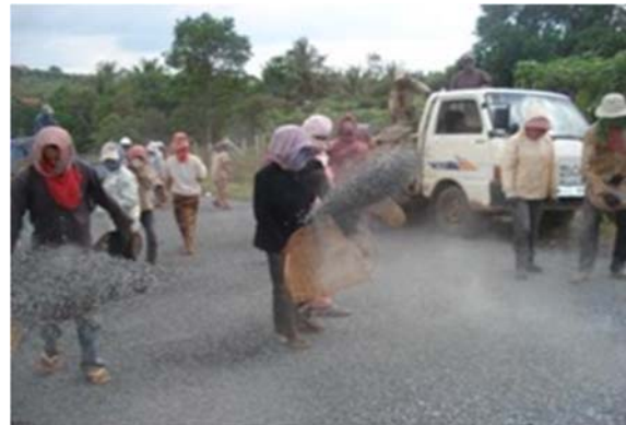
ការងារកសាងស្រទាប់បាតក្រោមក្រាលថ្មកិន៖ ការផ្គុំថ្មលាយកៅស៊ូ ដោយប្រើដៃ (ប្រភព៖ មន្ទីរសាធារណៈការ និងដឹកជញ្ជូនខេត្ត មណ្ឌលគិរី)
