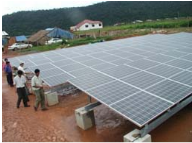
បន្ទះកញ្ចក់ស្រូបពន្លឺព្រះអាទិត្យ នៃរោងចក្រអគ្គិសនីដើរដោយថាមពល ព្រះអាទិត្យ និងជីវៈខ្សាច់ កំលាំង 120 kW នៅក្បែរក្រុងព្រះសីហនុ
